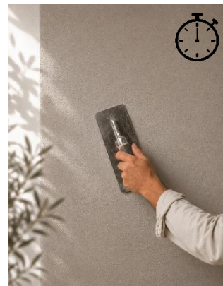
3. Aplicação da segunda demão do KONCRETO® R.
