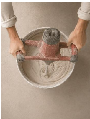
4. Homogeneização do componente A e B KONCRETO® F.
