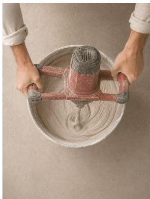
1. Homogeneização do componente A e B do KONCRETO® R.
