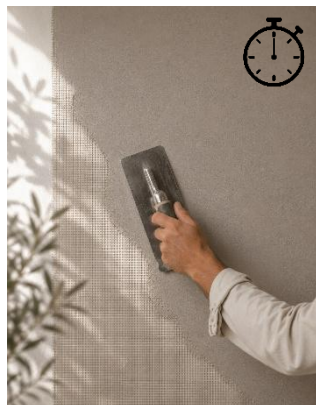
2. Colocação de rede sobre o substrato para aplicação da primeira demão do KONCRETO® R.
