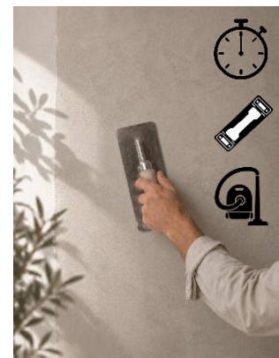
6. Aplicação da segunda demão do KONCRETO® F.
