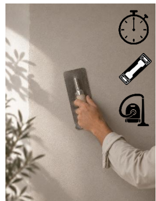
5. Aplicação da primeira demão do KONCRETO® F.
