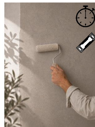
8. Aplicação de 2 a 3 demão de Top Coat Acetinado/Top Coat BS/Top Coat P Ultra Matte 9
