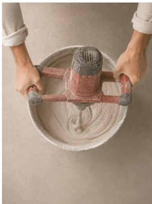
4. Homogeneização do componente A e B KONKAL® F.
