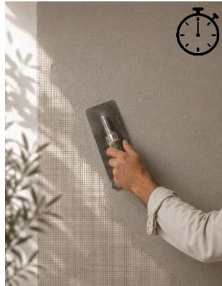
2. Colocação de rede sobre o substrato para aplicação da primeira demão do KONKAL® R.
