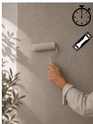
7. Aplicação de uma demão de Selante Acrílico.
