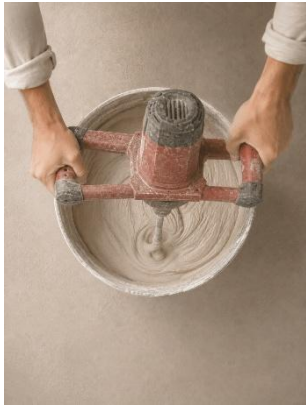
1. Homogeneização do componente A e B do KONKAL® R.
