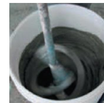
4. Homogeneização do componente A e B do KONCRETO® F.
