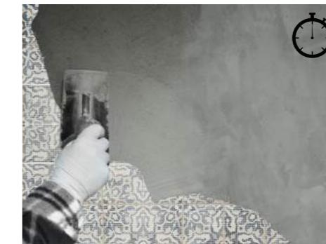
2. Colocação de rede sobre o substrato e aplicação da primeira demão do KONCRETO® R.
